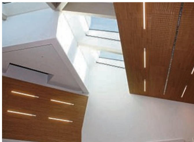
Das Forum in ganz neuem Licht: Eingebaute Dachfenster lassen mehr Tageslicht hinein, die Beleuchtung wurde erneuert und die Veranstaltungstechnik auf den aktuellsten Stand gebracht.
