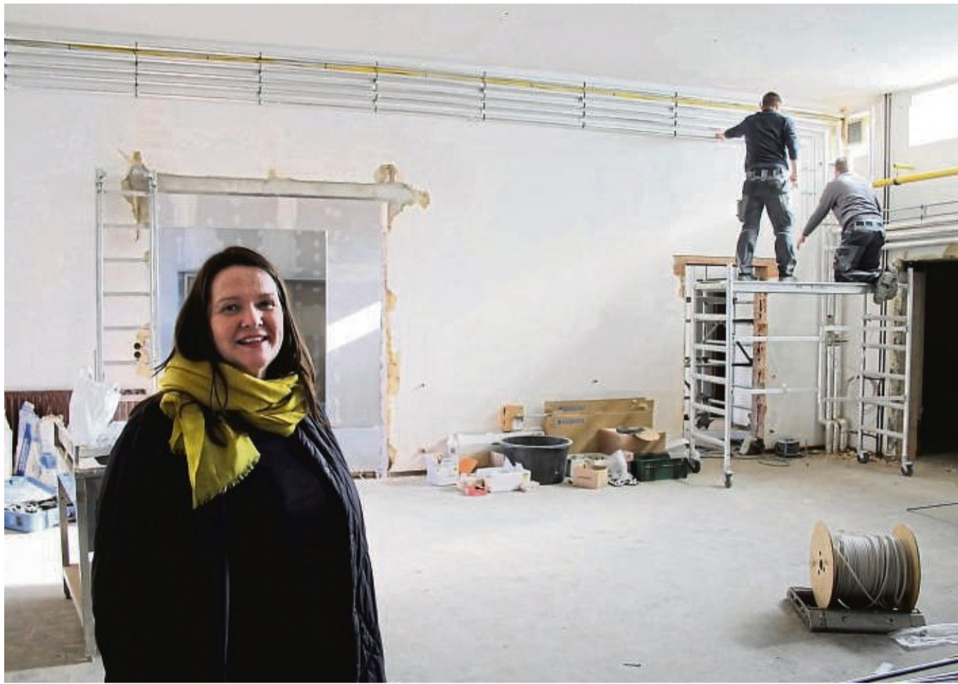
Neue Räume in der Alten Post: In einigen Wochen wird hier die Lebensmittelausgabe der Hofgeismarer Tafel stattfinden. Tafel-Koordinatorin Frauke Wiegand besichtigte jetzt die Baustelle und freut sich über den baldigen Umzug. FOTO: GERD HENKE
