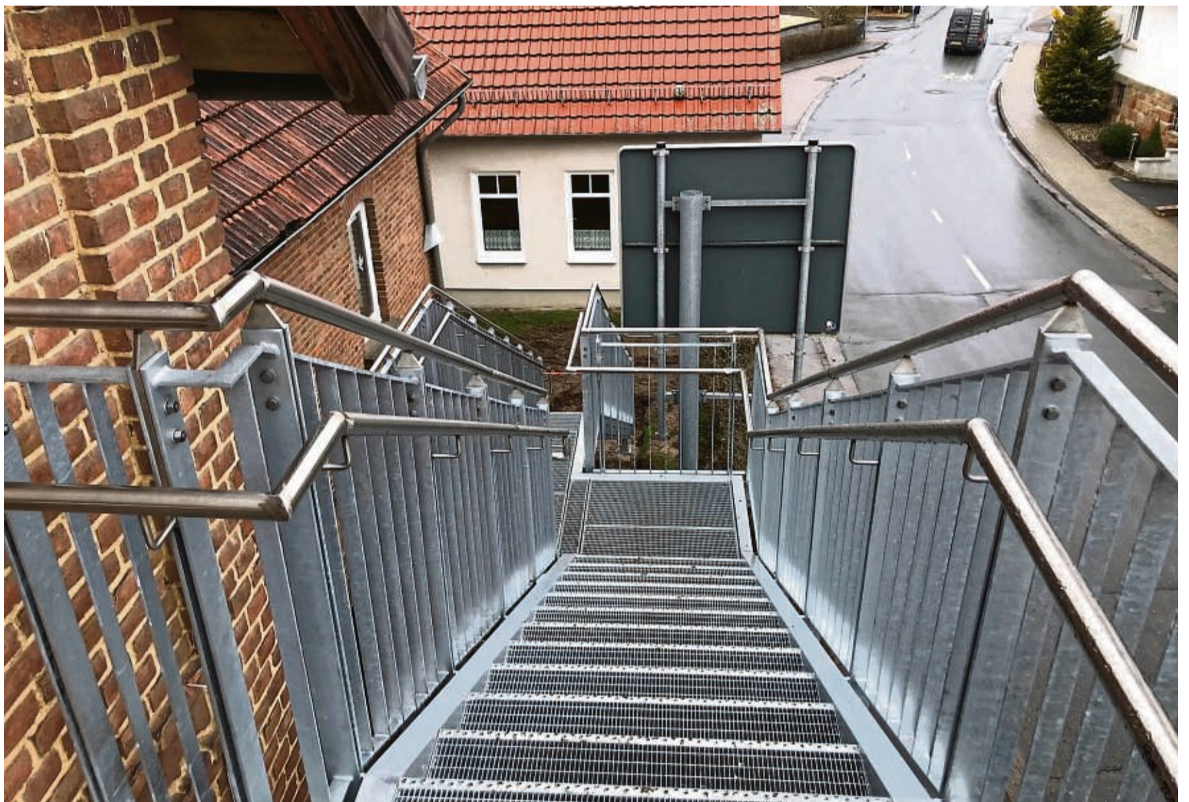
Der rettende Weg ins Freie: Der führt für Schüler und Lehrer im ersten Stockwerk der Grundschule Ippinghausen über eine neue Stahlstreppe. FOTO: ANTJE THON
