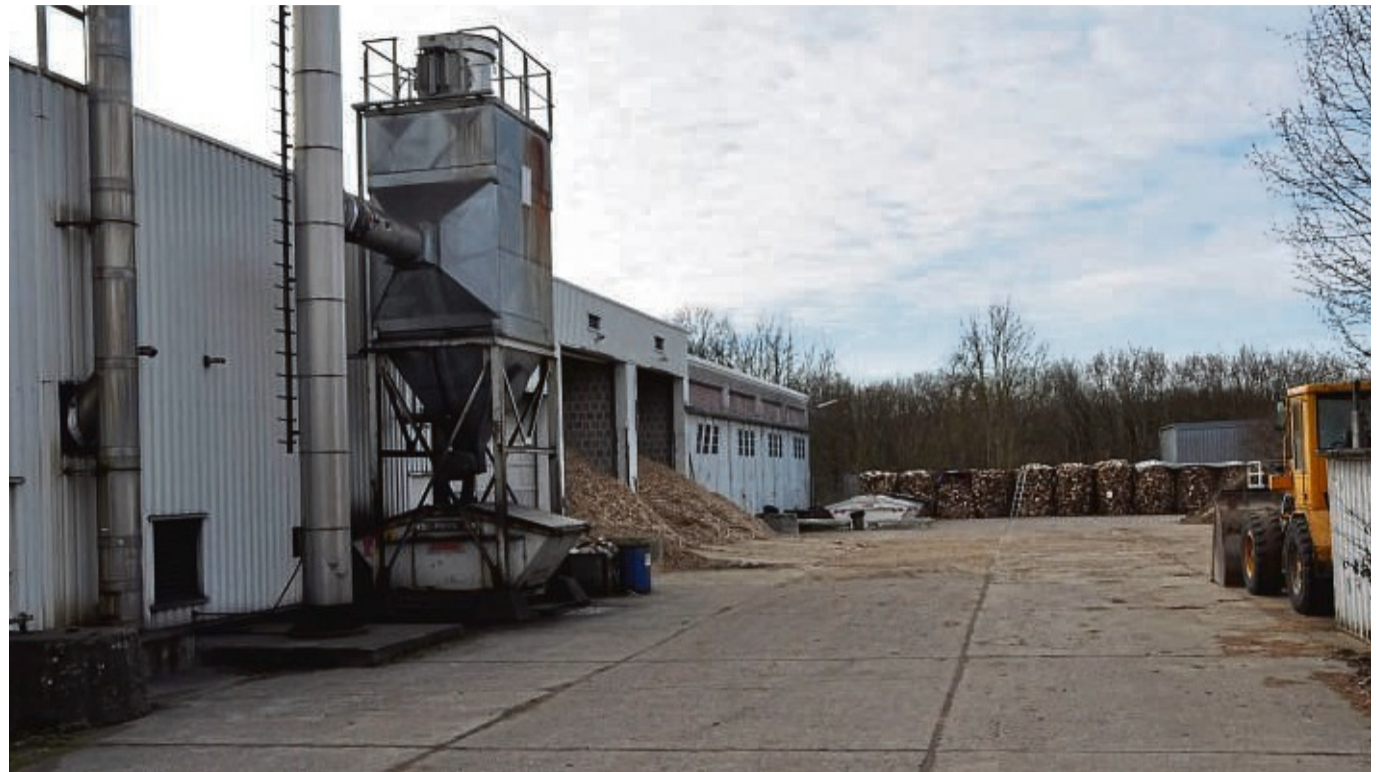
Von außen unscheinbar, aber im Kern die Lösung für viele Energieprobleme: Die Bad Arolser Nahwärme GmbH betreibt am Freizeitbad Arobella ein Heizkraftwerk, in dem das unbehandelte Holz gebrauchter Paletten verfeuert wird.
