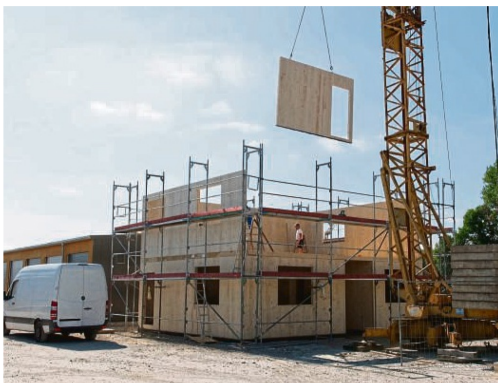
Auf der Baustelle: Montage eines Gebäudes mit CLT-Wandelementen des Ante-Unternehmenszweigs HBS.
