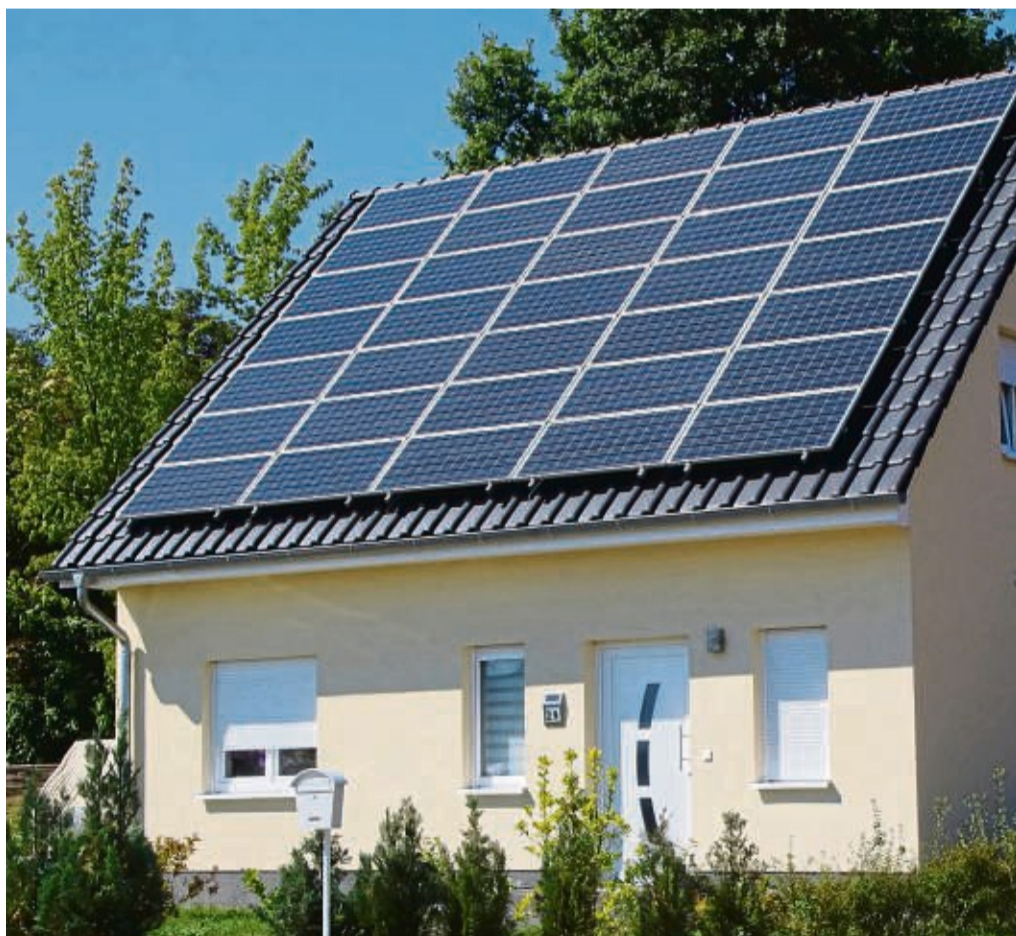
Sonnenstrom vom Dach: Im Laufe der Zeit haben sich einige Irrtümer in Bezug auf Photovoltaik-Anlagen in das allgemeine Bewusstsein geschlichen.
