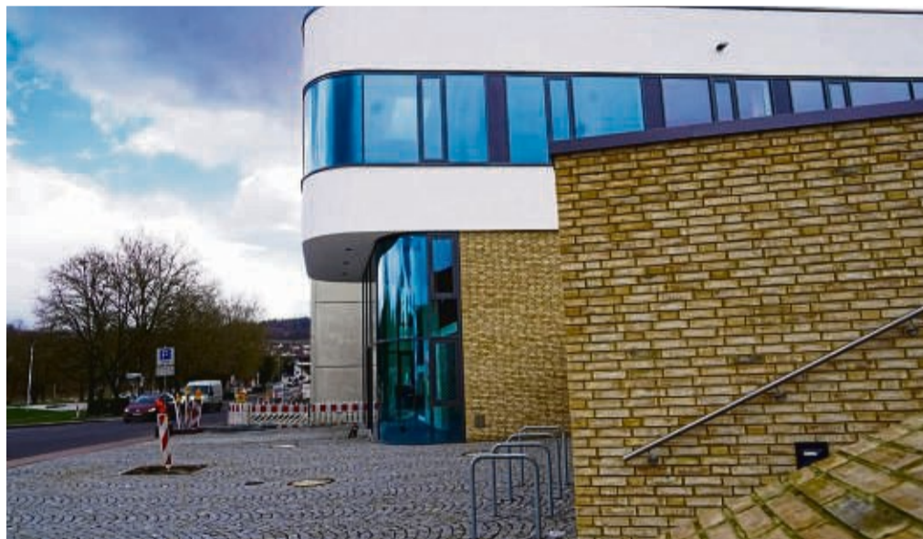
Die Baumaßnahmen der Kreissparkasse sind mittlerweile abgeschlossen – entstanden ist ein modernes und zeitgemäßes Gebäude.
