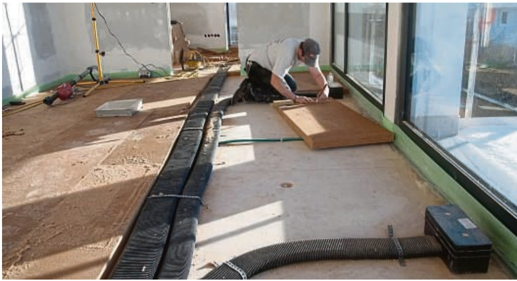
Die Zuluftleitungen für eine zentrale Lüftung werden im Fußboden verlegt.
