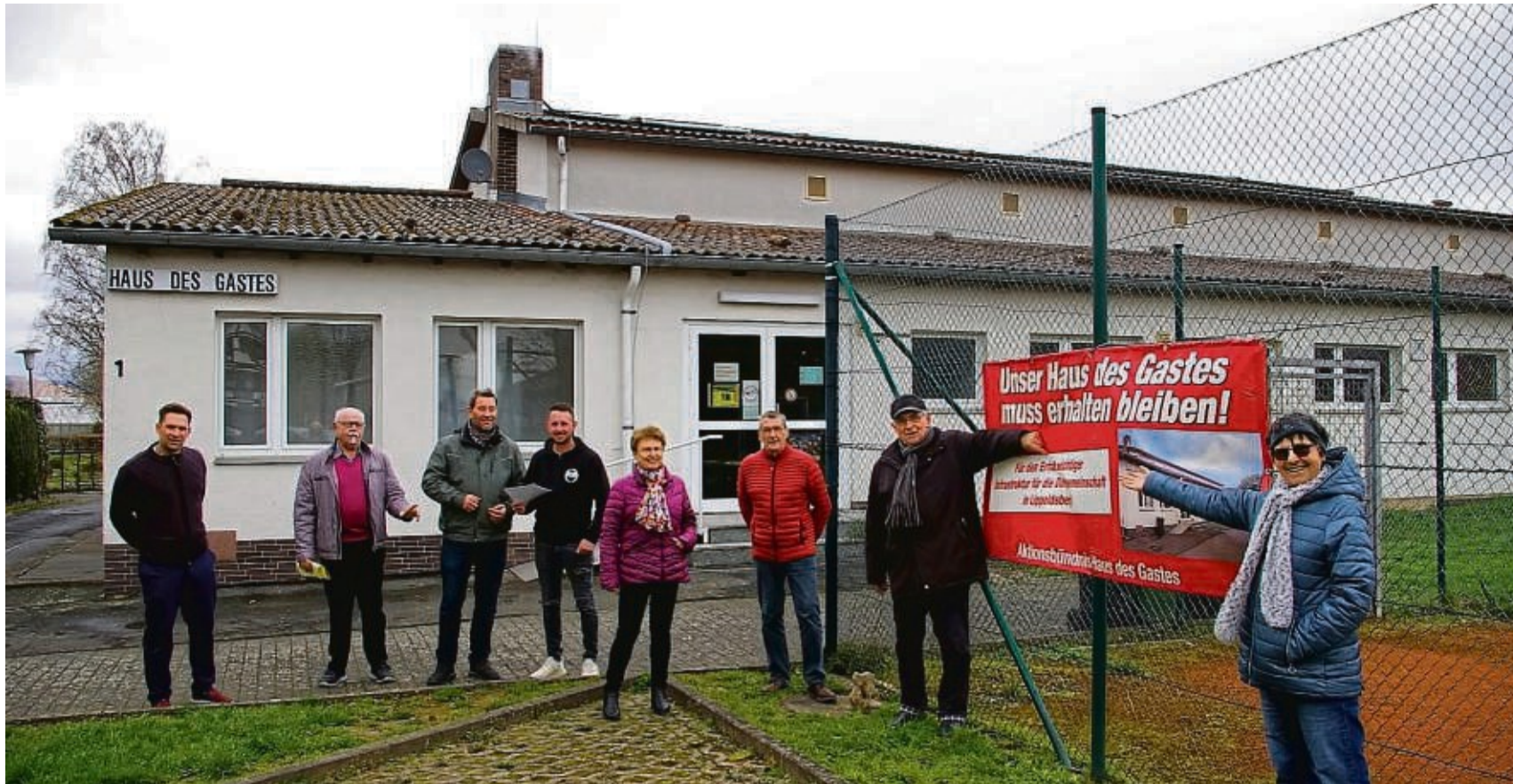
Die Bürgerinitiative „Lippihill“ in Lippoldsberg will das Haus des Gastes erhalten und wurde in ein Förderprojekt der Staatskanzlei aufgenommen. Am Treffen nahmen teil (von links): Martin Elberskirchen, Robert Mildner, Peter Kleinadel, Timo Dake, Martina Stüber, Wilfred Schuck, Altbürgermeister Horst Heusner und Anita Ternner.
