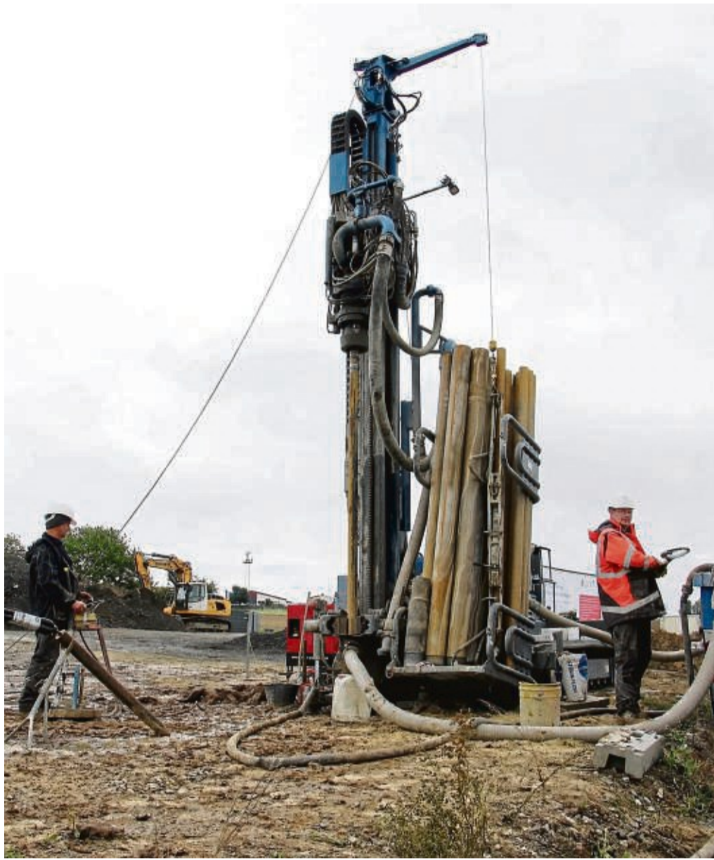
Eine klimaschonende Heizquelle: Die Geothermie oder Erdwärme. In Vellmar und Habichtswald wurden in den vergangenen Jahren Probebohrungen vorgenommen.
