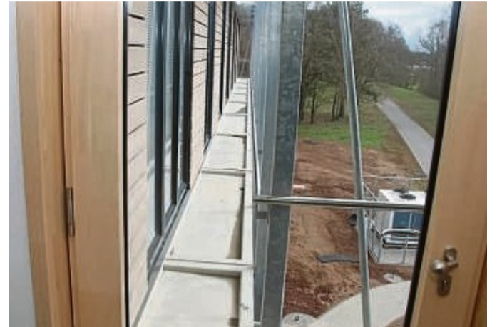
Die umlaufenden Balkone verhindern den Sonneneintrag bei hochstehender Sommersonne und dienen der Wartung und Fensterreinigung. FOTO: PHILIPP DAUM
