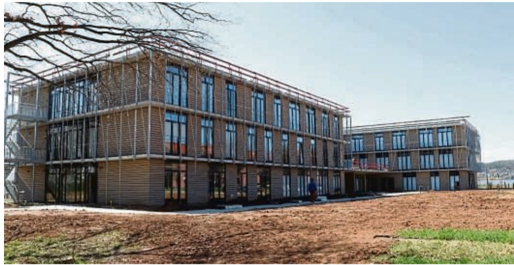
Aktuell haben die Umzüge in das neue Verwaltungsgebäude des Landkreises Waldeck-Frankenberg am Südring in Korbach begonnen. Rund 80 neue Parkplätze sind zudem entstanden. FOTO: MARCUS ALTHAUS
