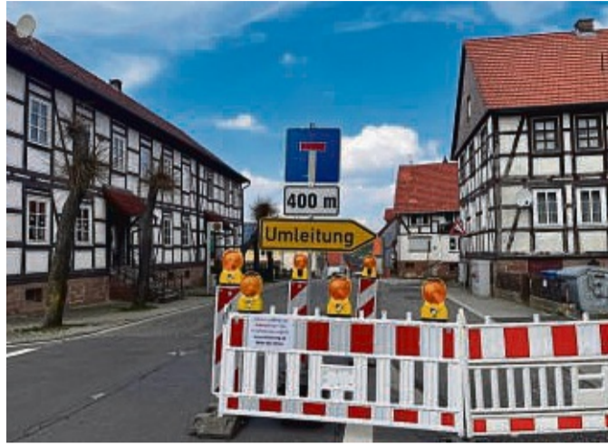
Die Ortsdurchfahrt ist gesperrt. Nahkauf und MVZ sind durch Umleitungen zu erreichen.
