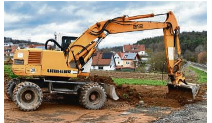
Rekultivierung und Wegebau: Mit dem Rückbau von Zwischenlagern und der Wiederherstellung von Wirtschaftsweegen endete jetzt die Bahn-Großbaustelle Wiesenfeld.
