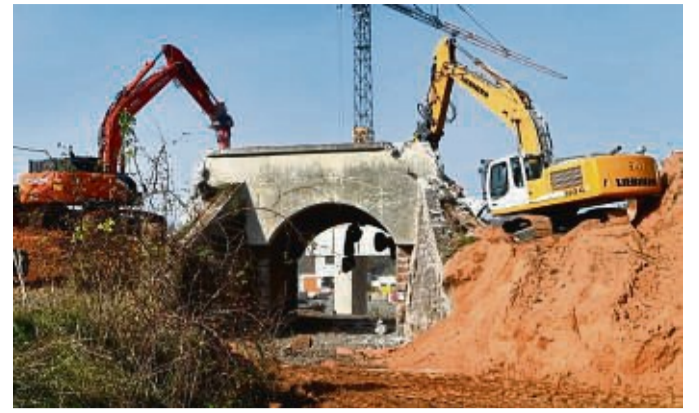
Großeinsatz beim Abriss: Innerhalb des genau festgelegten Zeitrahmens der Zugverkehr-Sperrpause mussten die alten Unterführungen abgerissen und ersetzt werden.
