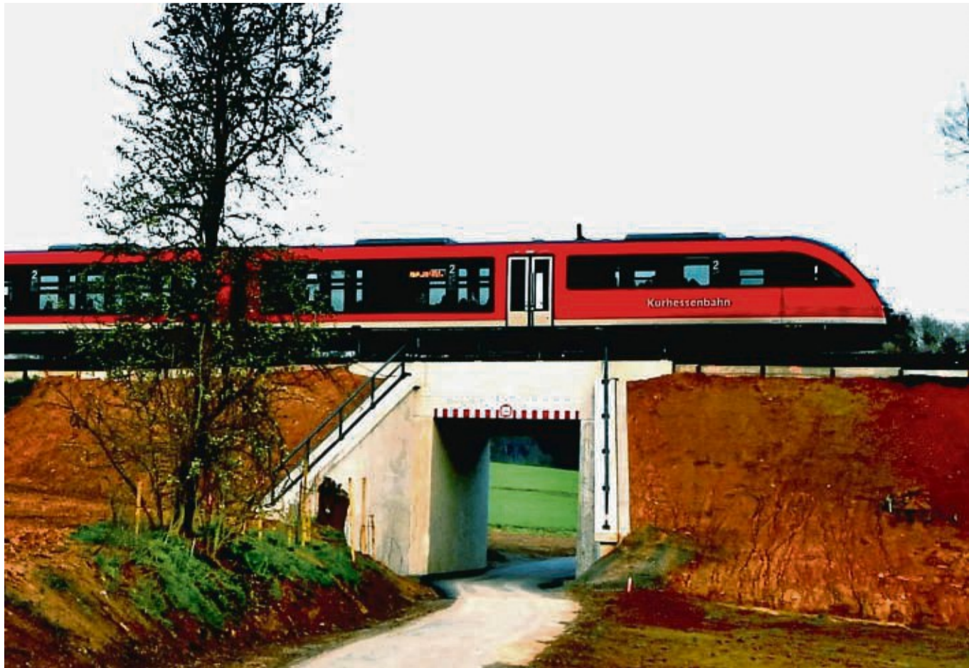
Die Burgwaldbahn rollt: Bereits seit November läuft der Zugverkehr über den beiden neuen Stahlbetonrahmenbauwerke, die in der zweiwöchigen Sperrpause eingebaut worden waren. Zuletzt wurden nun Feldwege und als Zwischenlager verwendete landwirtschaftliche Flächen wieder hergestellt.
