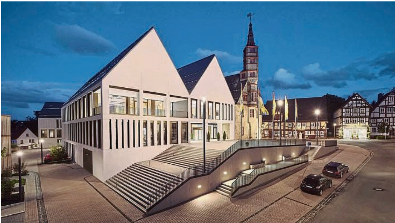
Flexibles System: Die Beleuchtung am Korbacher Rathaus wurde prämiert.
