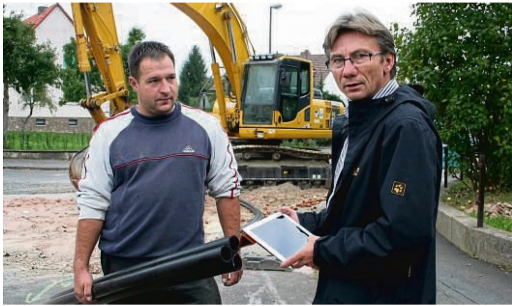
Mitgedacht: Bei Kanalarbeiten wurden in der Vergangenheit in Heringen gleich Leerrohre verlegt. Unser Archivbild zeigt Marcus Limburg von der Baufirma Giebel und den damaligen Bürgermeister Hans Ries.
