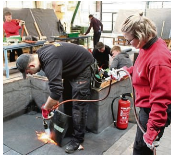
Überbetriebliche Ausbildung der Dachdecker-Auszubildenden im Berufsbildungszentrum Korbach. Auszubildende bei der Herstellung der ersten Abdichtungslage für ein Flachdach. FOTO: KREISHANDWERKERSCHAFT
