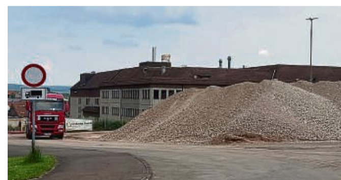
Auf und am ehemaligen Wilke-Areal in Berndorf sind die Sanierungsarbeiten im ersten Abschnitt weitgehend abgeschlossen.
