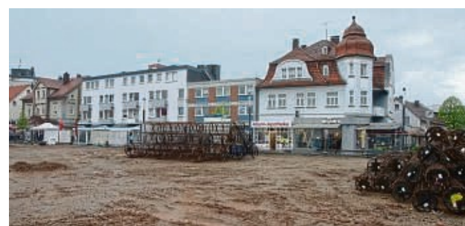
Auf der Baustelle auf dem ehemaligen Woolworth-Gelände in Korbach tut sich seit Wochen nichts.
