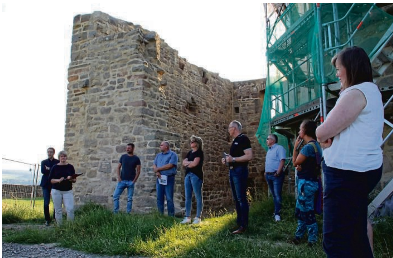
Vor Ort: Der Bauausschuss an der Kugelsburg. Noch steht das Gerüst am Turm, bald wird es entfernt.
