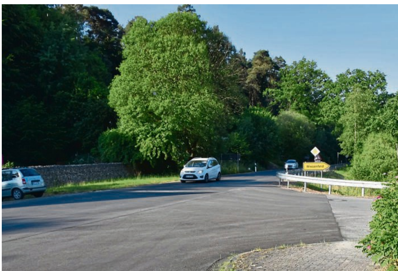
Die Zeit der langen Umwege ist vorbei: Die Kreisstraße 117 zwischen Burgwald und Ernsthausen ist nach elfwöchiger Sanierung wieder geöffnet. Die Wiesenfelder haben wieder direkten Anschluss an die Nachbarorte. FOTO: MARTINA BIEDENBACH
