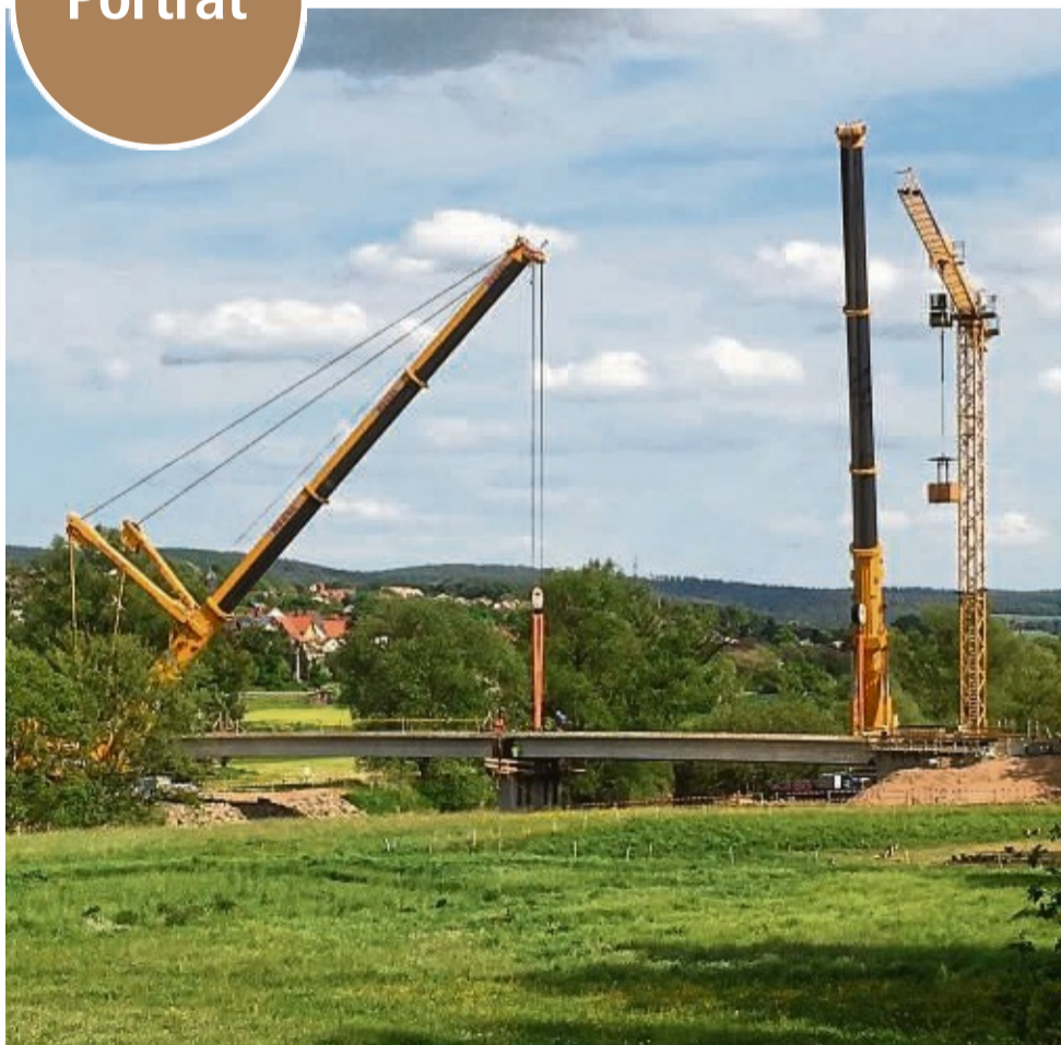
Neubau: Kräne halten Teile der neuen Brücke, die zwischen Körle und Wagenfurth über die Fulda führt.
