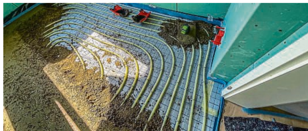
Nur beim Einbau ist sie zu sehen: Die Fußbodenheizung verschwindet danach unter einem Estrich.
