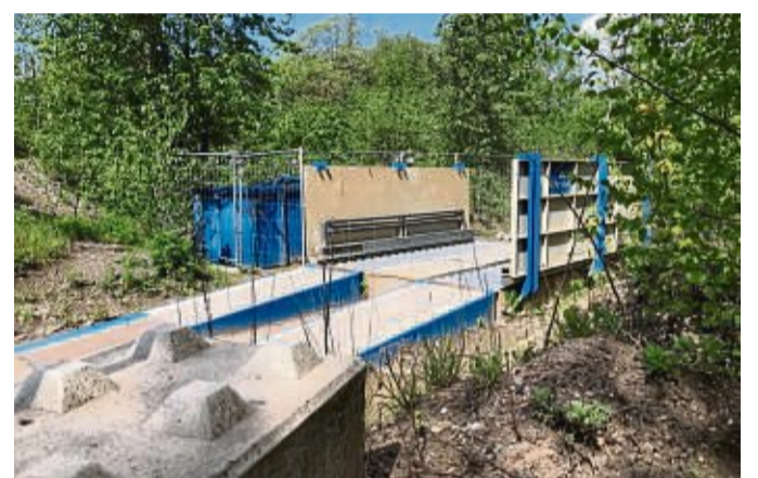
Lkw, die die Waschanlage nutzen, verlassen das Gelände mit sauberen Reifen.
