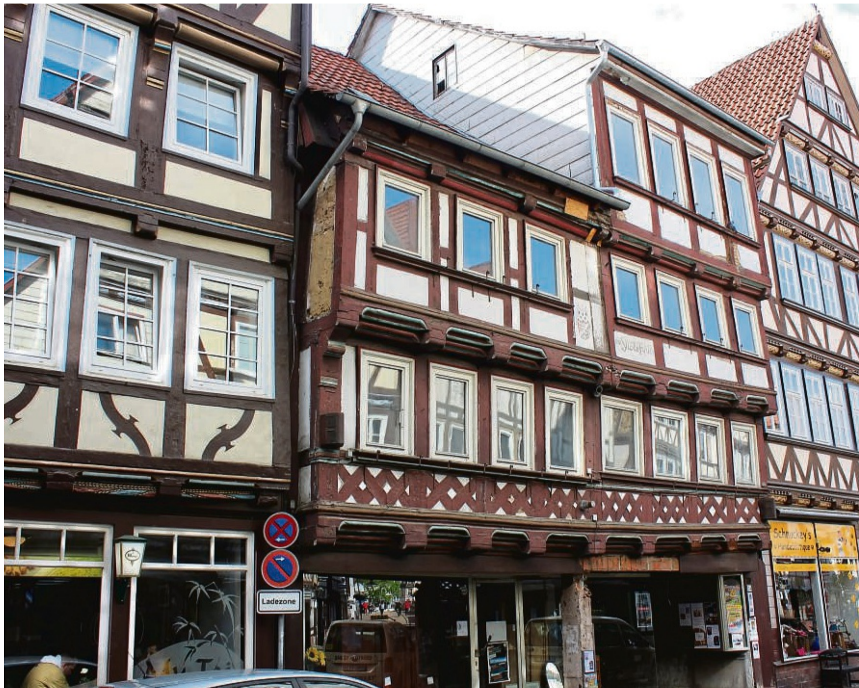
Der Silberfuchs (Mitte) ist seit Jahren sanierungsbedürftig. Derzeit laufen Voruntersuchungen, „um zu ermitteln, wie mit dem Silberfuchs weiter verfahren werden soll“, teilte die Stadt Hann. Münden als Eigentümerin mit.
