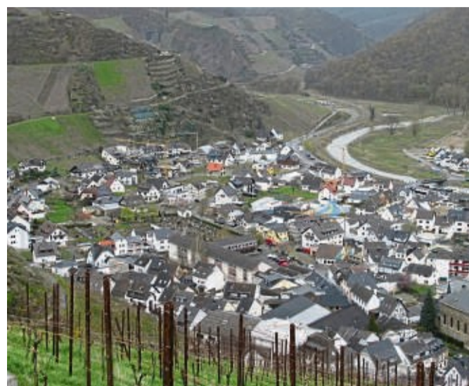
In Altenahr gibt es immer noch zahlreiche Baustellen – davon zeugen die vielen Kräne und auch das Zirkuszelt rechts im Bild, wo derzeit das Parlament tagt.
