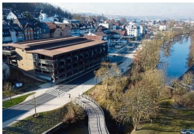
Die Tages des Parkhauses an der Uferstraße in Frankenberg sind gezählt. Die Stadt wird den Bau einreißen lassen um, mehr Platz für die Studierenden und die Technische Hochschule Mittelhessen zu schaffen.
