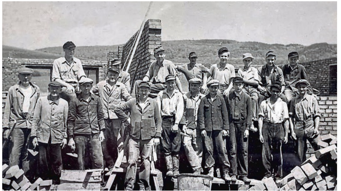
Erinnerung an den Anfang: Die Vackiner Bauunternehmung GmbH & Co. KG begann ihren Betrieb im Jahr 1948 in Sehlen. Unser Bild entstand 1949 und zeigt die Mitarbeiter am Stallneubau von August Bornscheuer in Altenhaina. Im Vordergrund (Siebter von links) ist Firmengründer August Vackiner zu sehen.
