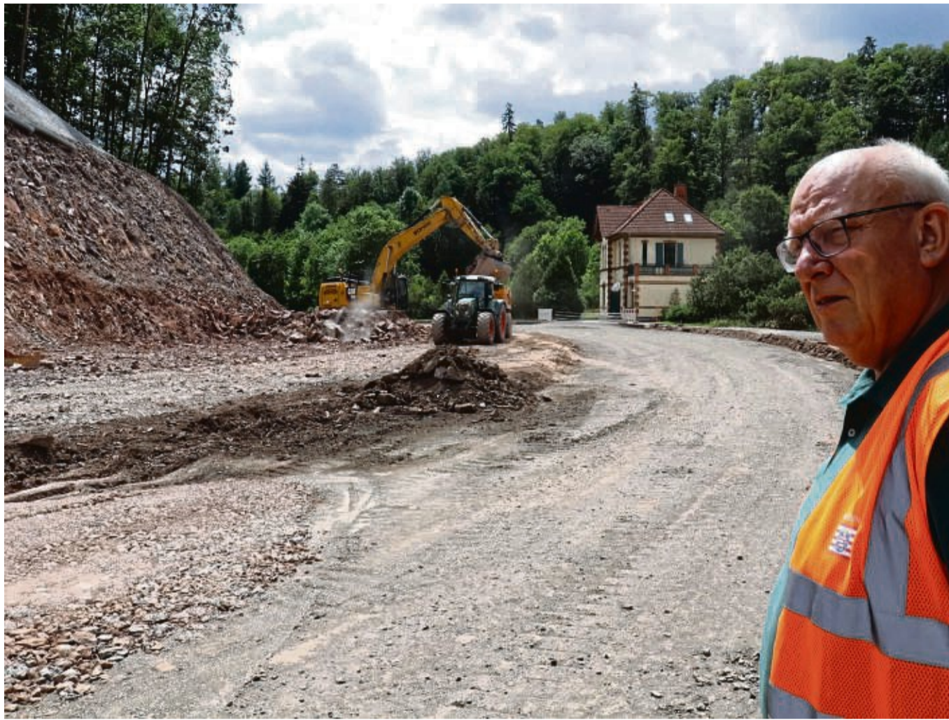
Hartes Gestein verzögert die Arbeiten: Vorgestern ist hier die letzte einer ganzen Reihe von Sprengungen erfolgt, wie Dr. Hellwig Kamm von Hessen Mobil mitteilt. FOTOS: MARCUS ALTHAUS
