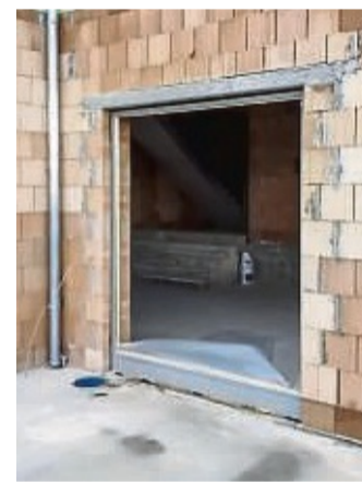
Dank der Montagezarge werden Baustellenschäden vermieden und das Fenster in der trockenen Bauphase eingebaut.
