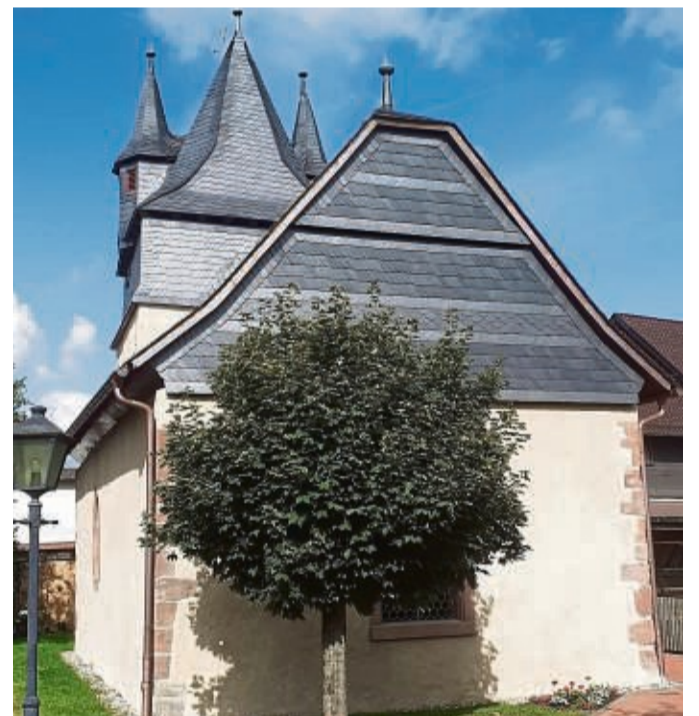
Ansicht der renovierten Kirche aus Westen.
