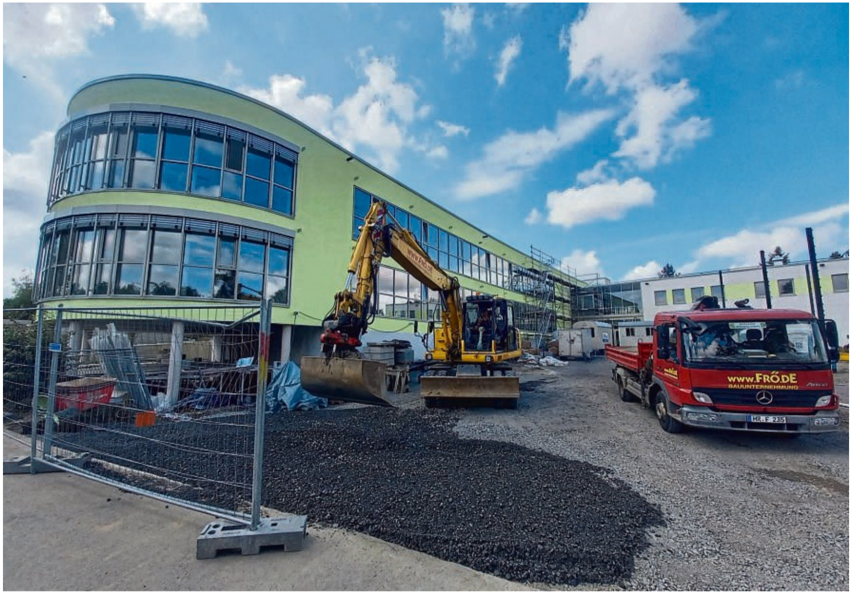
Bauarbeiten auf der Zielgeraden: Die sanierte Helenentalschule steht nach den Herbstferien ab 28. Oktober für den Schulbetrieb zur Verfügung.
