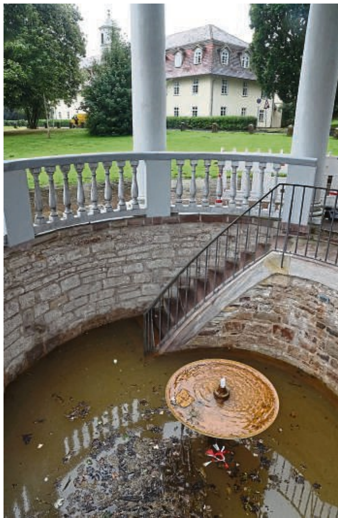
Überflutet: Der Brunnentempel in Hofgeismar steht nach Starkregen und Pumpenausfall zwei Stufen hoch unter Wasser und ist gesperrt.
