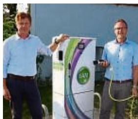
Ladesäule: Armin Schülbe und Thomas Eckhardt nehmen die E-Ladesäule auf dem Parkplatz Breitwiese in Betrieb. FOTO: STADT SONTRA
