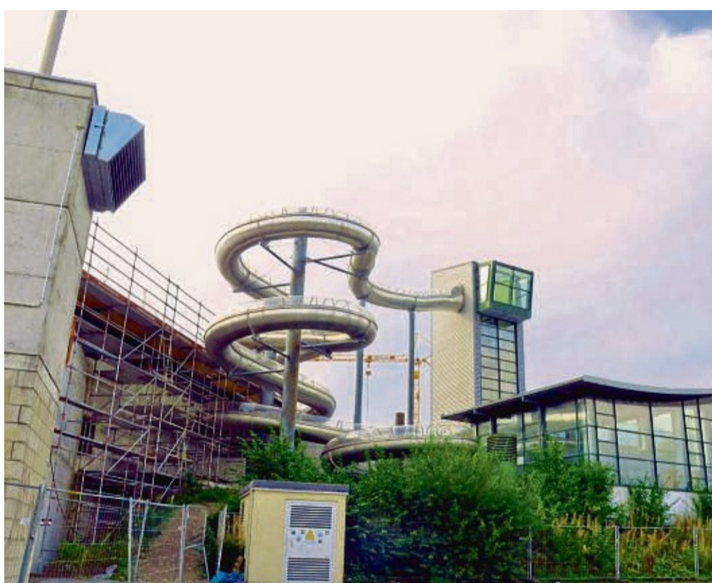
Der Neubau des Lagunenbades in Willingen macht laufend Fortschritte, wird aber teurer.
