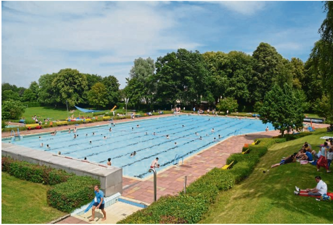
Nach mehr als 60 Jahren ist das Korbacher Freibad reif für eine Sanierung. Ein Gutachten hat gravierende Mängel festgestellt und empfiehlt einen umfangreichen Umbau.
