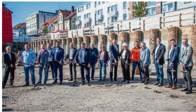
Symbolischer Spatenstich: Der Woolworth-Neubau in der Korbacher Fußgängerzone geht in die entscheidende Phase. Das 23-Millionen-Euro-Projekt soll Ende 2024 fertiggestellt sein.
