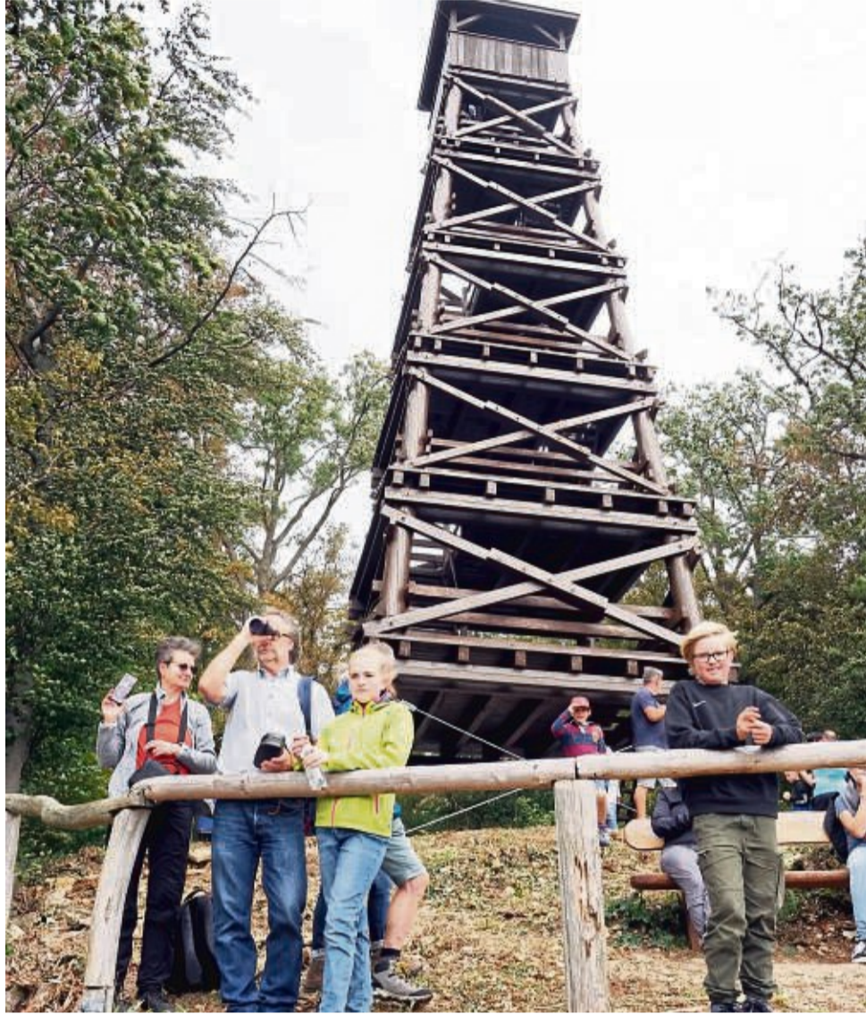
Frisch saniert: Der Plesseturm ist endlich wieder begehbar.
