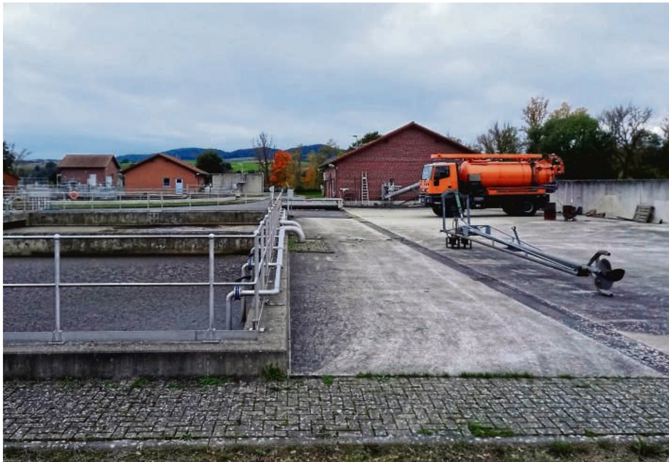
Für den Saugspülwagen des Bauhofs (rechts), der künftig fest an der Bergheimer Kläranlage stationiert bleiben soll, wird voraussichtlich eine winterfeste, 230 000 Euro teure Fahrzeughalle gebaut, die auch weitere Geräte und Fahrzeuge aufnehmen kann. Das Projekt spielt eine Rolle in der jüngsten Diskussion um Sanierung oder Neubau des Edertaler Bauhofes.
