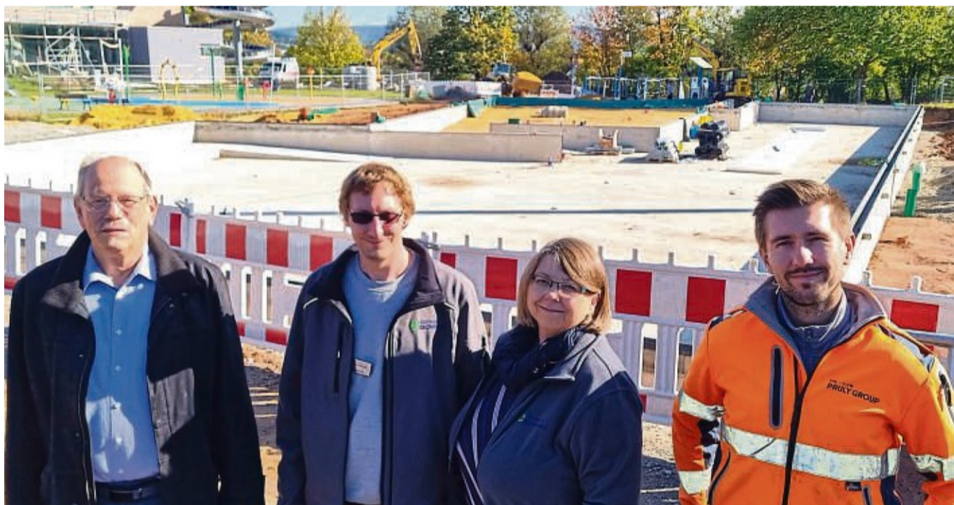
Haben den Baufortschritt im Freibad begutachtet: Ralf Herrmann von den Stadtwerken, Oliver Degenhardt und Violetta Schüttemeyer vom Espada sowie Sergej Stürmer von der bauausführenden Pauly Group. FOTO: TOBIAS STÜCK
