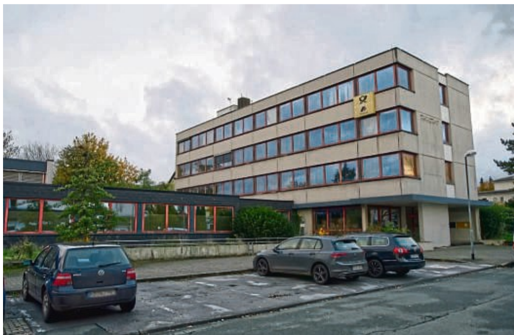
Das alte Post-Gebäude in Korbach: Der Investor Cureus plant hier eine Seniorenresidenz mit Tagespflege und Betreutes Wohnen, der Projektstart ist auf 2024 verschoben. FOTO: L. BENSELER
