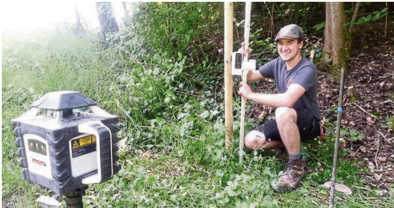
Der Bau des Amphitheaters: Justus Kröger nimmt die Höhenmessung für die Oberkante des ovalen Theaters vor.
