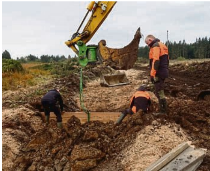
Der Einbau einer Bohlenwand aus Holz im Hauptentwässerungsgraben erfolgt unter Anleitung von Forstwirtschaftsmeister Martin Hennemuth.
