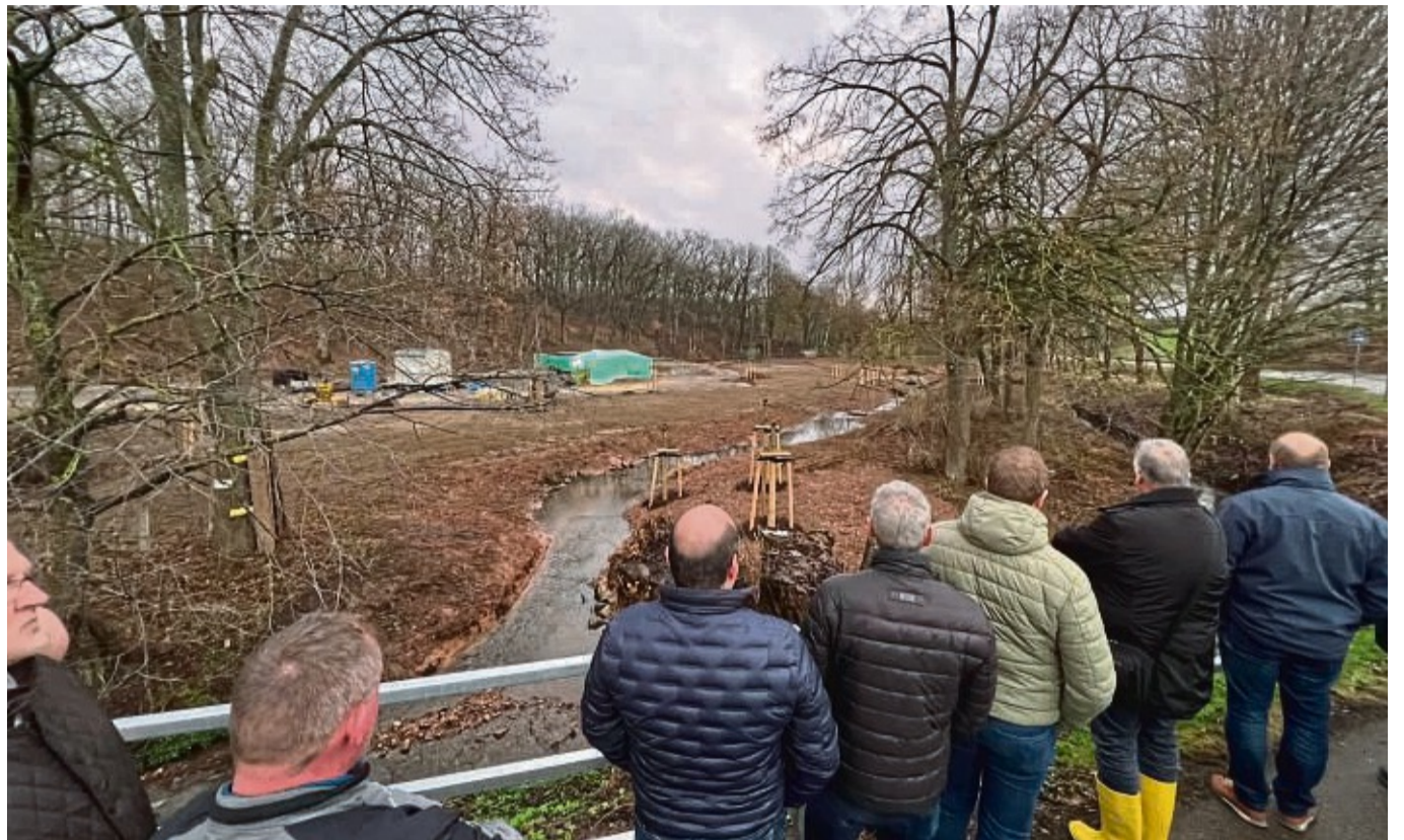
Die Renaturierung der Thiele-Aue verlangt im zweiten Bauabschnitt einen bisher nicht eingeplanten Bodenfilter zur Reinigung des Regenwassers, das aus dem Wohngebiet Albert-Schweitzer-Straße in 19 Rohren in den Bach geleitet wird. Das Foto entstand vor einem Jahr bei einem Ortstermin.
