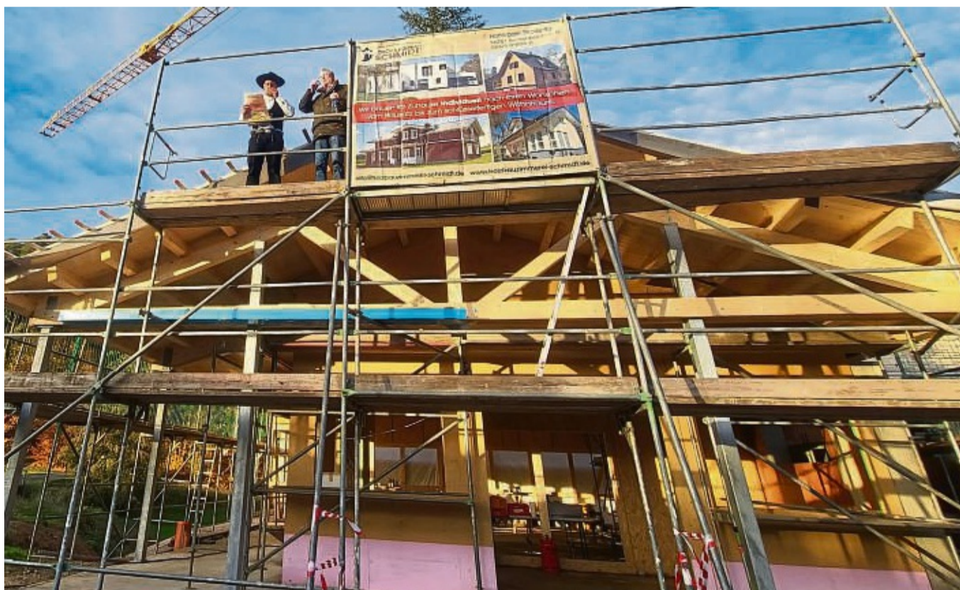
Richtfest: Das neue Multifunktionsgebäude am Silbersee nimmt Gestalt an. Den Richtspruch sprachen Zimmermeister Dennis Keil (links) und Bürgermeister Volker Jaritz.
