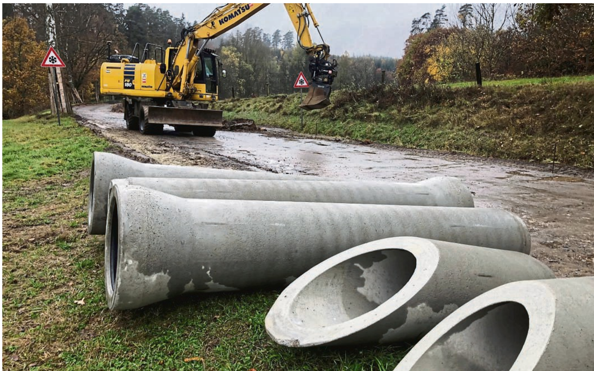
Bauarbeiten auf der B 251 kommen langsam voran: Die Fahrbahn zwischen Ippinghausen und Höhnscheid ist abgefräst, am Montag waren Bauarbeiter im Bereich des Langen Rods aktiv.
