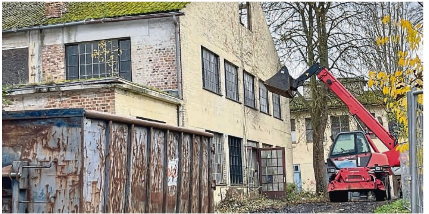
Die Abbrucharbeiten an der Immenhäuser Glashütte haben begonnen. Zunächst werden Schadstoffe entfernt und die Hallen entkernt.
