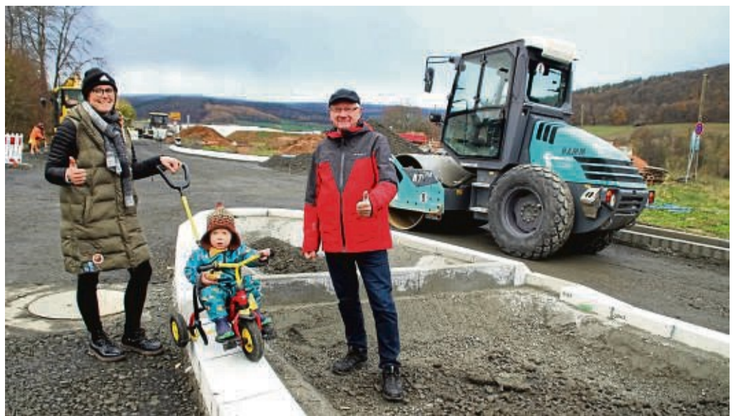
Freuen sich auf die Eröffnung der ausgebauten Bundesstraße 487 in Adelshausen: Virginia Jost mit Sohn Bruno und Ortsvorsteher Wolfgang Fröhlich.
