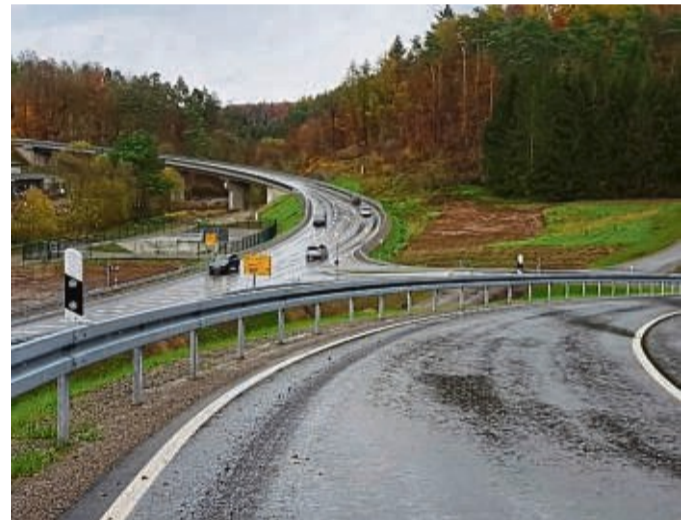
Die neuen Ortsumgehungen B 252 für Dorffitter (Bild) sowie zwischen Münchhausen und Wetter sind am 20. Oktober eröffnet worden. FOTO: MARIANNE DÄMMER
