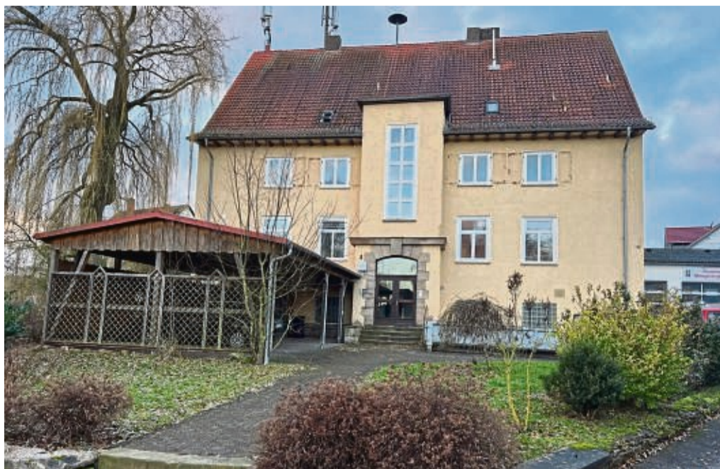
Die ehemalige Polizeistation in Mengerlinghausen wird nun für die Aufnahme eines Kindergartens umgebaut. Das Provisorium ist auf drei Jahre angelegt.
