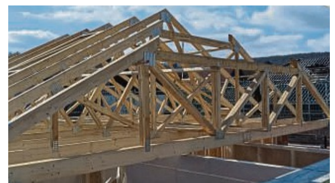
Der Dachstuhl wurde mit Nagelbindern frei über die Außenwände gespannt.
