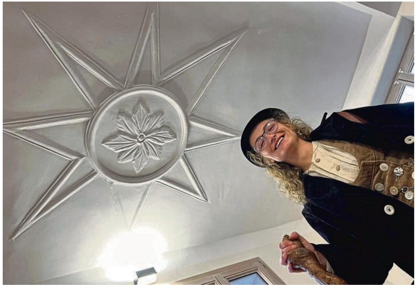
Unter einem guten Stern hat die Wanderschaft der 28-jährigen Carolin Kimm begonnen, die nach der dreijährigen Lehre bei Stuckateurmeister Jochen Siebert in Ehringen auf die Walz geht. Das Foto entstand im Haus Mittelstraße 5 in Ehringen, ihrer letzten großen Baustelle. Hier legte sie auch den achtzackigen Stern mit Blumenornament frei und restaurierte ihn nach allen Regeln der Handwerkskunst.
