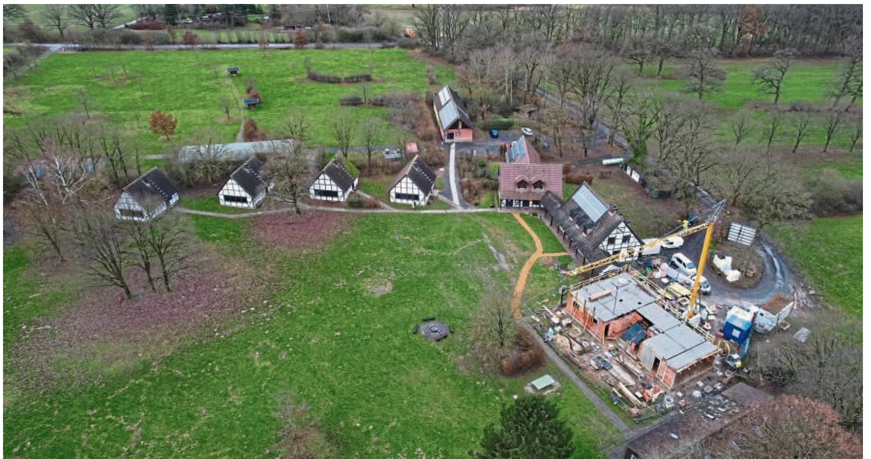
Das Zentrum Pfadfinden in Immenhausen: vorn rechts der Rohbau des Küchenhauses. In den Fachwerkhäusern oben stehen die bereits sanierten Gruppenräume zur Verfügung.
