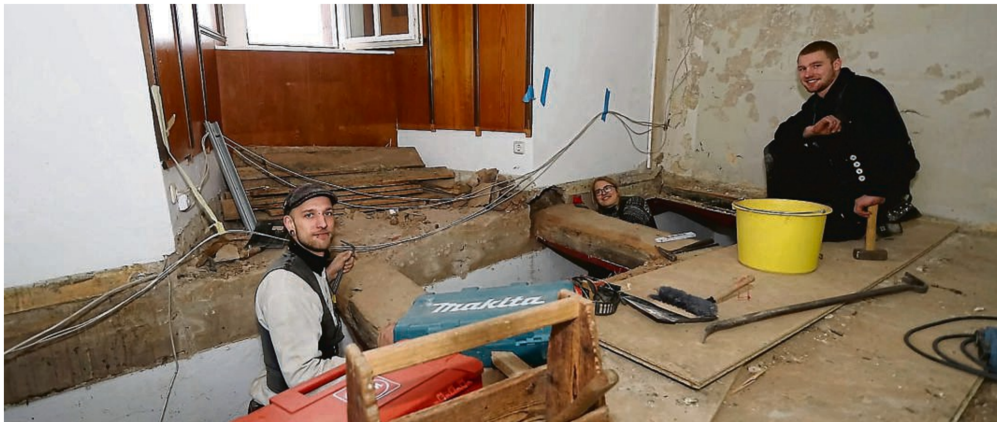
Beim Erneuern des Fußbodens der „Ehrenamtsstube“ kamen Gabriel Krapf (von links), Miriam Kinkel und Malte Schaubbruch mächtig ins Schwitzen.
