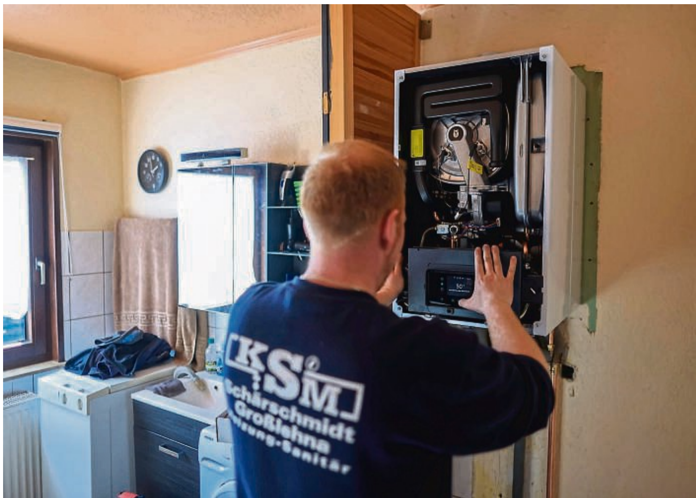
Eine energetische Sanierung macht viele Umbaumaßnahmen nötig, die der Staat fördert. Der Handwerker sollte aber nicht beginnen, bevor der Antrag auf Förderung raus ist.
