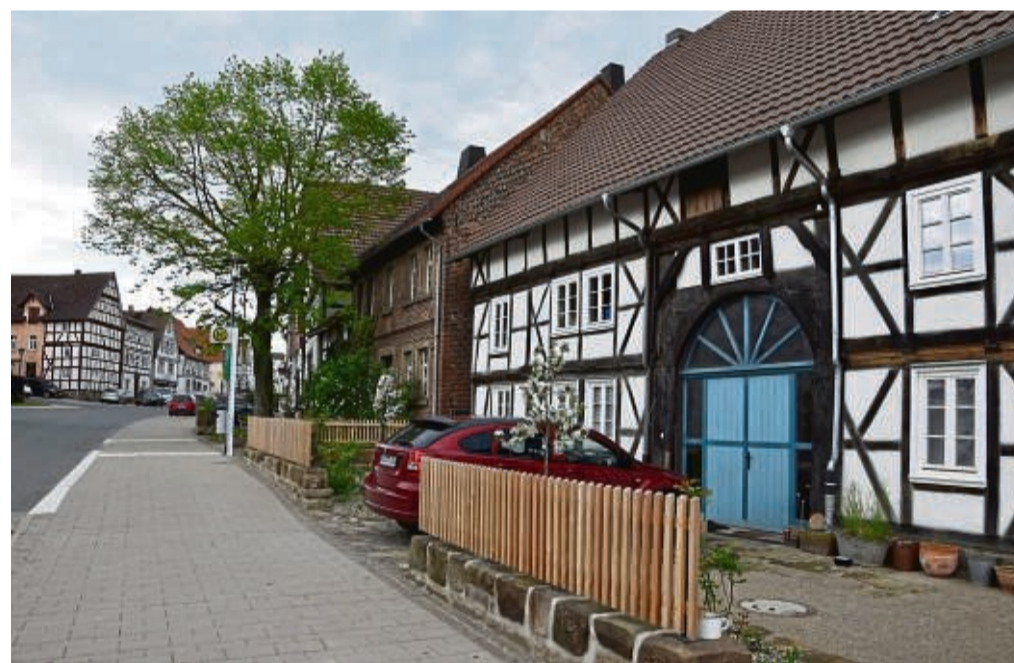
Vorzeige-Ergebnis der Stadtsanierung in Rhoden: Das sanierte Fachwerkhäuschen an der Landstraße.
