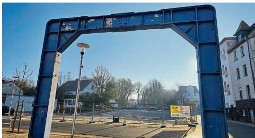
Freier Blick: Das ehemalige Centralkaufhaus Ceka in der Bahnhofstraße Borken ist abgerissen. FOTO: CLAUDIA BRANDAU
